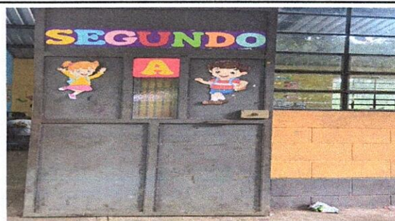
FOTO 2: MANTENIMIENTO DE PUERTA INCLUYE CAMBIO DE CHAPA
