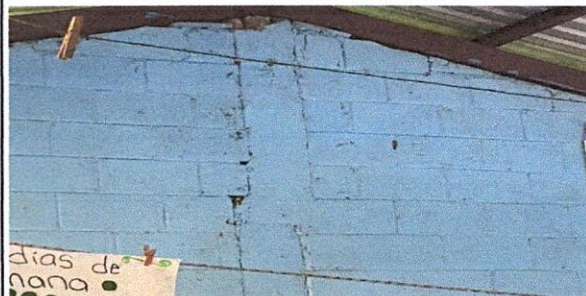
FOTO 4: SUMINISTRO DE SELLADO + REPELLO
