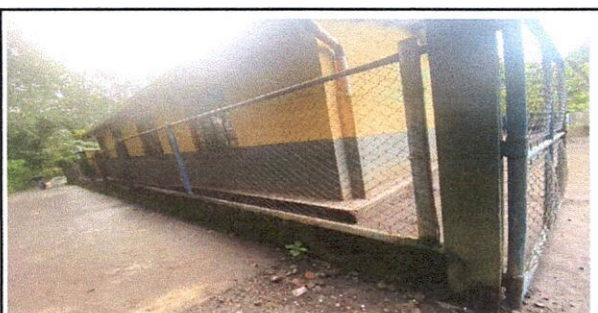
FOTO 5: APLICACIÓN DE PINTURA Y LOSA DE CONCRETO
