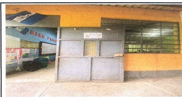
FOTO 6: SUSTITUCION DE PUERTA
