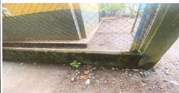
FOTO 3: SUSTITUCION DE MALLA GALVANIZADA
