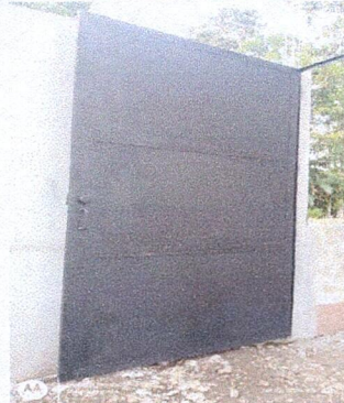
Foto 2: Sustitución de puerta 1.20 x 2.00 por puerta con marco de tubo Ø 2" más malla galvanizada incluye pasador (incluye pago de mano de obra)
