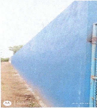
Foto 1: Suministro de block para circulación de muro perimetral (incluye columnas de 0.15 x 0.15 x 1.00 mt con hierro Ø 1/2" est. 1/4 + solera U con hierro Ø 3/8" est. 1/4")
