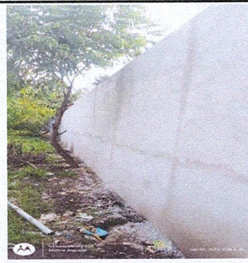
Foto 4: Suministro de block para circulación de muro perimetral (incluye columnas de 0.15 x 0.15 x 1.00 mt con hierro Ø 1/2" est. 1/4 + solera U con hierro Ø 3/8" est. 1/4")
