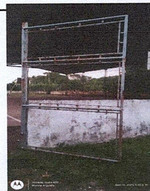
FOTO 6: Sustitución de puerta 1.20 x 2.00 por puerta con marco de tubo Ø 2" más malla galvanizada incluye pasador (incluye pago de mano de obra)
