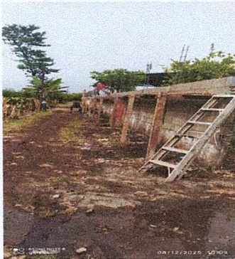
FOTO 1: suministro de block para circulacion de muro perimetral (incluye columnas de 0.15 x 1.00 mt con hierro 1/2" est. 1/4 + solera U con hierro 3/8" est. 1/4"
