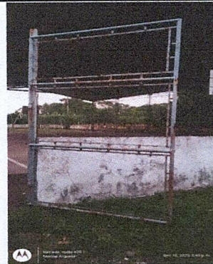
Foto 2: Sustitución de puerta 1.20 x 2.00 por puerta con marco de tubo Ø 2" más malla galvanizada incluye pasador (incluye pago de mano de obra)
