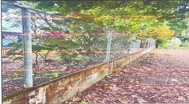
Foto 1: Suministro de block para circulación de muro perimetral (incluye columnas de 0.15 x 0.15 x 1.00 mt con hierro Ø 1/2" est. 1/4 + solera U con hierro Ø 3/8" est. 1/4"
