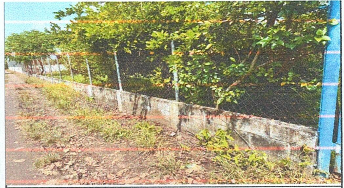
Foto 4: Suministro de block para circulación de muro perimetral (incluye columnas de 0.15 x 0.15 x 1.00 mt con hierro Ø 1/2" est. 1/4 + solera U con hierro Ø 3/8" est. 1/4"
