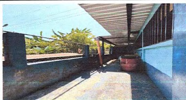
Foto 8: Suministro de canales y bajadas de agua pluvial
