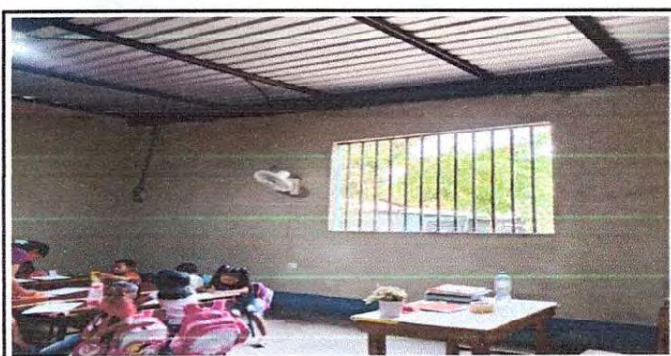
Foto 5: Suministro de ventanas de PVC y vidrio de 5mm, mantenimiento de balcones de estructura metálica.
