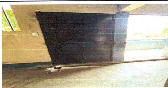
Foto 9: Mantenimiento de puertas de metal
