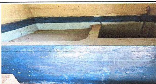
Foto 10: Sustitución de pila de concreto por mueble de concreto para lavamanos.
