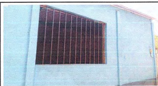
Foto 6: Vista externa suministro de ventanas de PVC y vidrio de 5mm, mantenimiento de balcones de estructura metálica.
