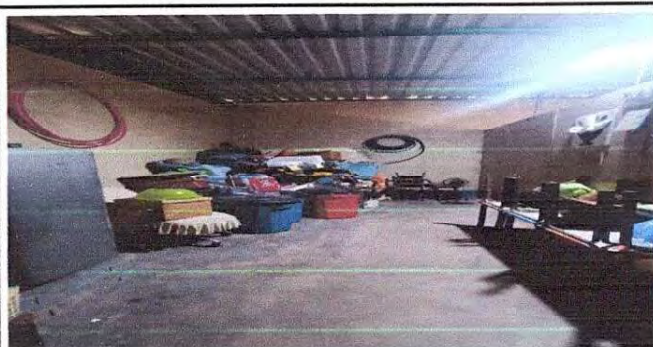
Foto 6: Reparación de áreas de cocina
