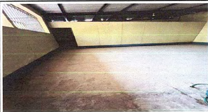
Foto 7: Sustitución de división de tablayeso y estructura metálica y sustitución de piso de concreto por piso cerámico
