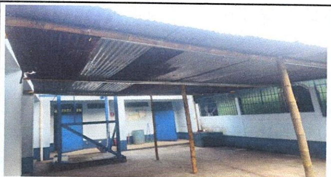
Foto 5: Instalación de Columnas de 20 cm x 25 cm x 5 mts de altura
