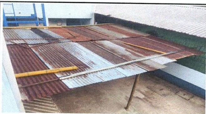
Foto 3: Sustitución de estructura de soporte de madera por metal y de techo de lámina por lámina troquelada aluzinc calibre 26 en el área recreativa del edificio educativo.
