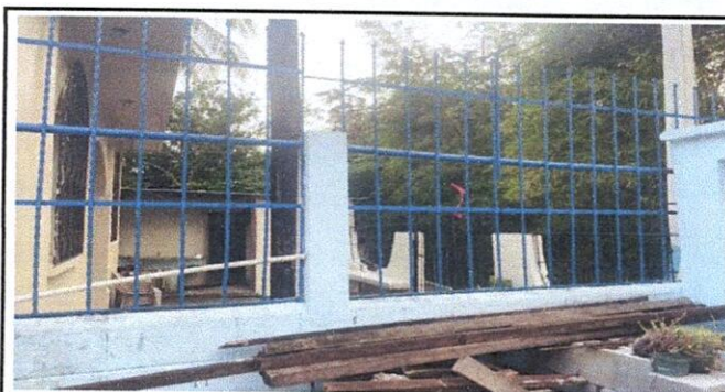
Foto 6: CONTINUACIÓN DE MURO PERIMETRAL DE BLOCK (SUSTITCIÓN DE BARANDA DE METAL EXISTENTE, INCLUYE HIERRO CEMENTO ARENA PIEDRIN BLOCK)
