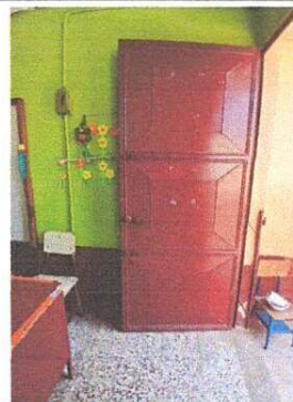
FOTO 4: MANTENIMIENTO DE PUERTA DE METAL
