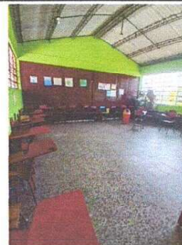
FOTO6: SUSTITUCION DE PISO POR PISO CERMAICO
