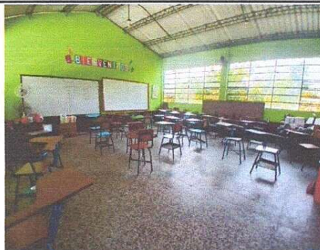
FOTO 2; SUSTITUCION DE PISO POR PISO CERAMICO
