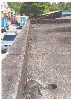
FOTO 1: IMPERMIABILIZACION EN LOSA
