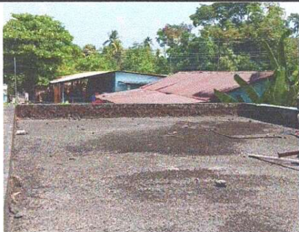
FOTO 5: IMPERMIABILIZACION DE LOSA
