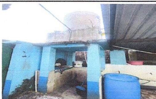
Foto 6: Sustitución de tubería principal de 1", suministro de bomba sumergible de 1 HP, sustitución de depósito de agua de 1,100 litros.
