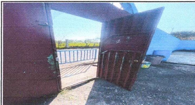
Foto 4: Sustitución de portón de ingreso de estructura metálica
