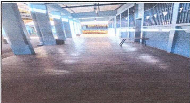
Foto 1: Sustitución de piso de torta de concreto por piso cerámico en aulas
