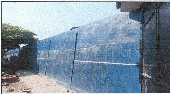
Foto 4: Reparación de muro perimetral de block 63*1 m2
