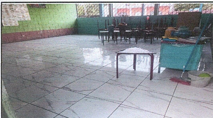
Foto2: Sustitución de piso de cemento liquido por piso cerámico
