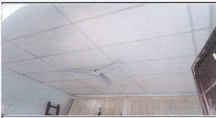
Foto 5: Suministro e instalación de cielo falso 4*4
