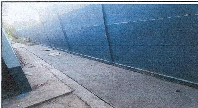
Foto3: Suministro de banquetta de concreto 33*1 m2
