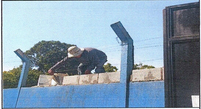
Foto 4: Reparación de muro perimetral de block 63*1 m2
