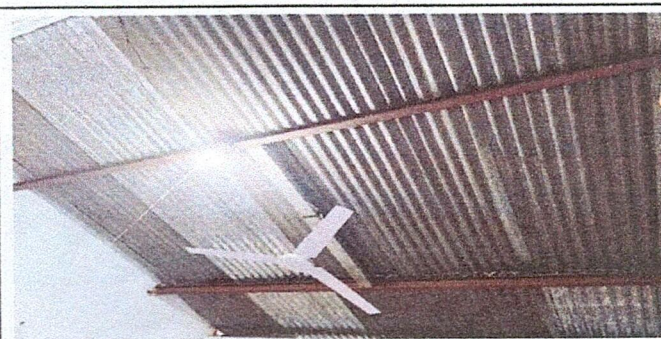
Foto 5: Suministro e instalacion de cielo falso 4*4
