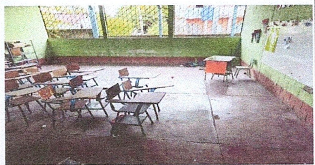
Foto 2: Sustrución de piso de cemento liquido por piso cerámico
