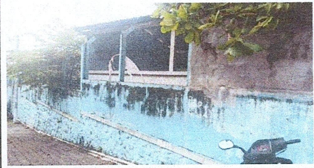
Foto 4: Reparación de muro perimetral de block. 63*1 m2
