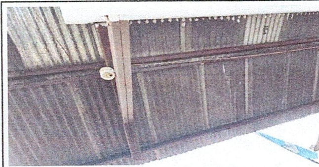
Foto 6: Sustrución de lámina, por lámina troquelada aluzinc calibre 26
