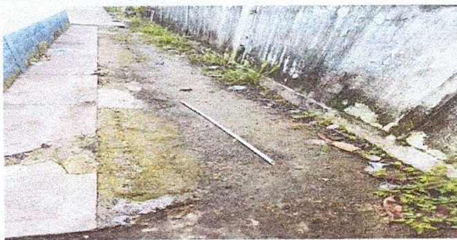
Foto 3: Suministro de banqueta de concreto 33*1 m2
