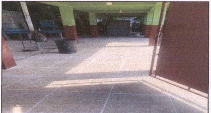
Foto 4: Sustrucción de piso de torta de cemento, por piso cerámico en modulo de aulas y corredor
