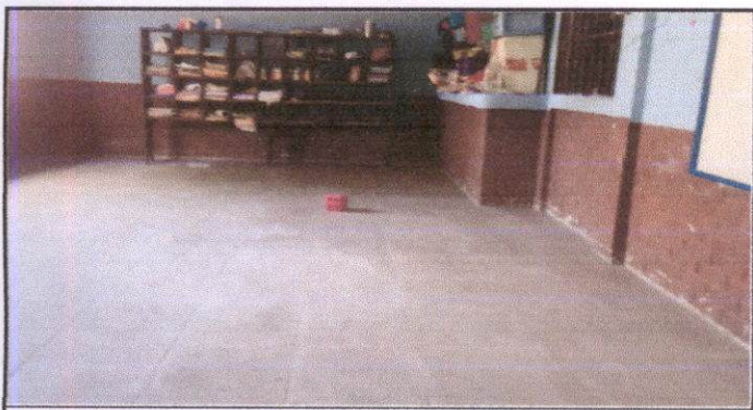
Foto 5: Sustrucción de piso de torta de cemento, por piso cerámico en modulo de aulas y corredor
