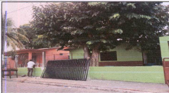
Foto1: Sustitución de tubo hg y malla galvanizada, por balcones tipo barrote
