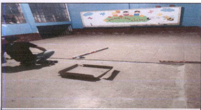
Foto 5: Sustitución de piso de torta de cemento, por piso cerámico en modulo de aulas y corredor
