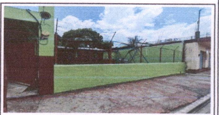
Foto 6: Sustitución de tubo HG + malla galvanizada por balcones de metal tipo barrote
