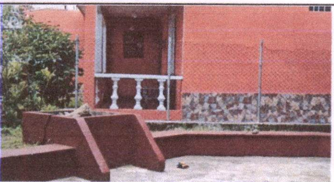
Foto 5: Sustitución de tubo HG + malla galvanizada por balcones de metal tipo barronte
