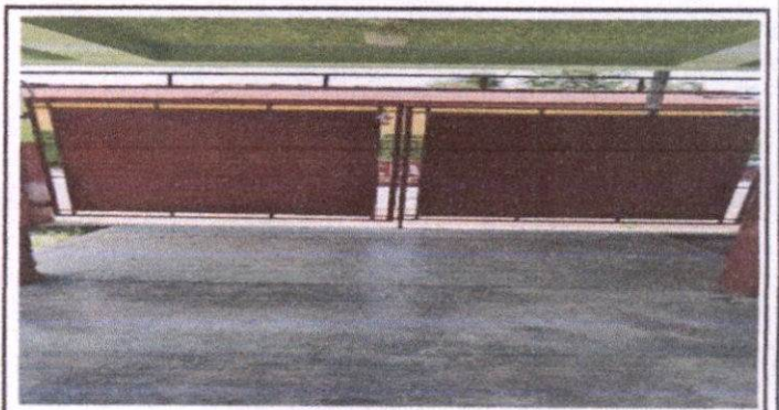
Foto 4: Sustitución de portón de metal
