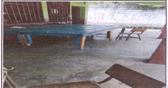
Foto 2: Sustitución de piso por piso cerámico en aulas
