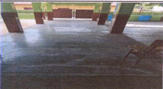
Foto 3: Sustitución de piso por piso cerámico en aulas
