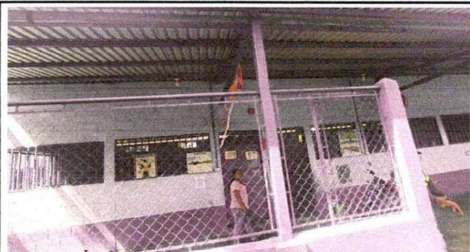
FOTO 1: INSTALACION DE BARROTES DE METAL EN MURO PERIMETRAL
