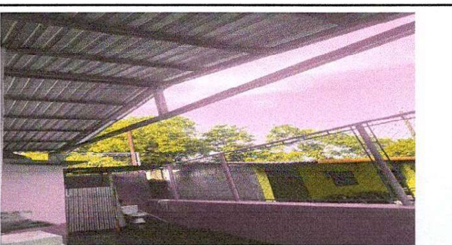
FOTO 6: AMPLIACION DE ESTRUCTURA DE SOPOR DE TECHO MAS CUBIERTA DE LAMINA TROQUELADA
