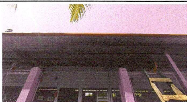
FOTO 2: SUSTITUCION DE CANAL TUBO PVC POR CANAL DE PVC
