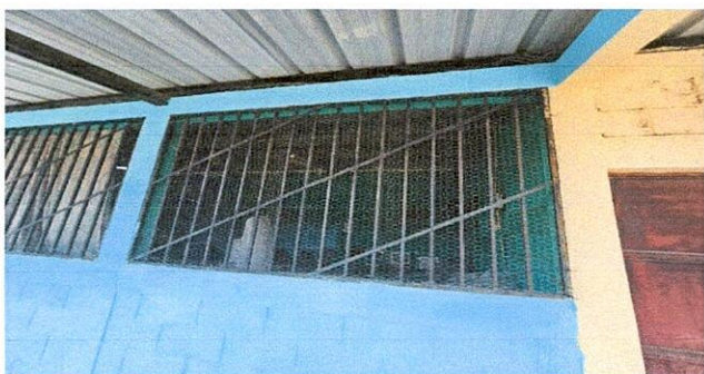
Foto 3: SUMINISTRO Y COLOCACION DE VENTANA DE PVC VIDRIO
