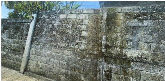
Foto1: REPARACIÓN DE MURO PERIMETRAL
