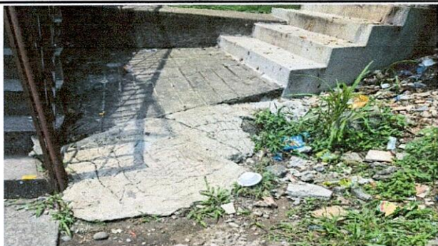
Foto 5: SUMINISTRO DE LOSA DE PATIO
