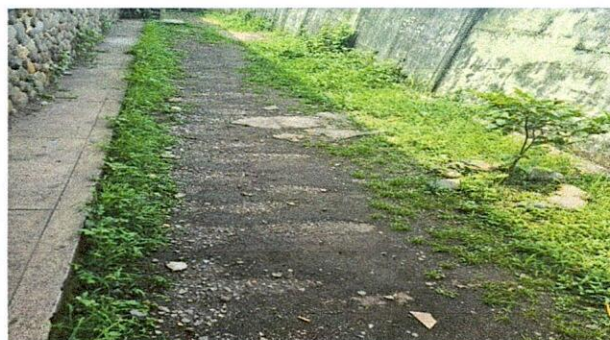
Foto 4: REPARACION DE BANQUETA DE CONCRETO
