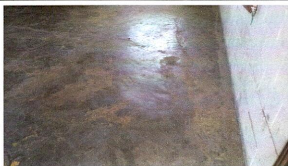
FOTO 3: SUSITUCION DE TORTA DE CONCRETO + SELECTO + COMPACATACION + FUNDICION
