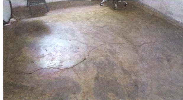
FOTO 2: SUSTITUCION DE TORTA DE CONCRETO + SUMINISTRO DE PISO CERAMICO
