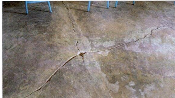
FOTO 4: SUSTITUCION DE TORTA DE CONCRETO + SELECTO+ COMPACTACION + FUNDICION.
