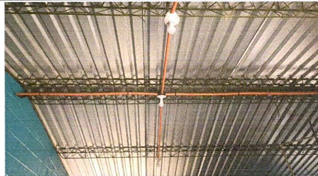
FOTO 2: SUSTITUCION DE ESTRUCTURA DE SOPORTE DE METAL
