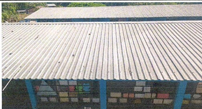
FOTO 1: SUSTITUCION DE CUBIERTA DE LAMINA
