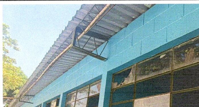
FOTO 3: CAMBIO DE ESTRUCTURA DE SOPORTE DE TECHO
