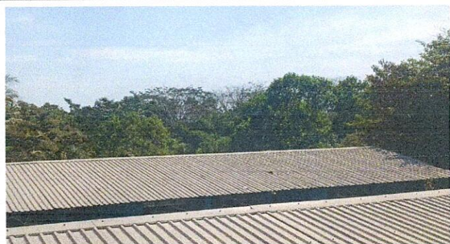
FOTO 4: SUSTITUCION DE CUBIERTA DE LAMINA
