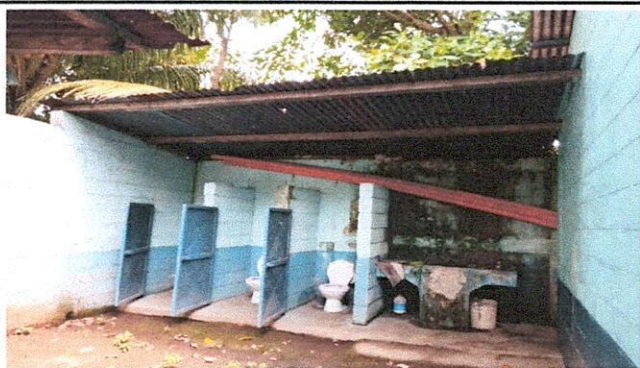
Foto 3: Sustrucción de estructura portante de soporte y de techo de lámina por lámina troquelada aluzinc calibre 26 en todo el edificio educativo.
