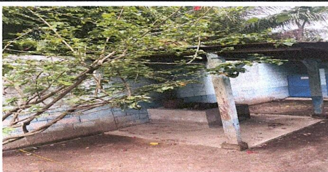
Foto 5: Sustrucción de estructura portante de soporte y de techo de lámina por lámina troquelada aluzinc calibre 26 en todo el edificio educativo.
