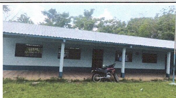
Foto 2: Sustitución de de lámina, por lámina troquelada aluzinc calibre 26
