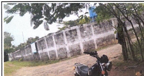
Foto 6: Aplicación de pintura en muro perimetral (área exterior e interior)
