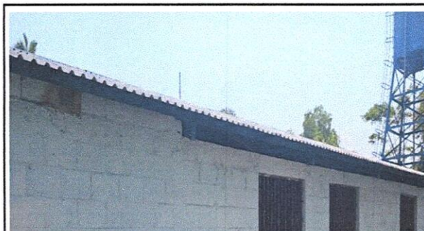
Foto 4: Cerramiento de área superior de muro de aulas
