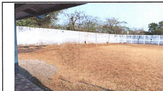
Foto 5: Aplicación de pintura en muro perimetral (área exterior e interior)
