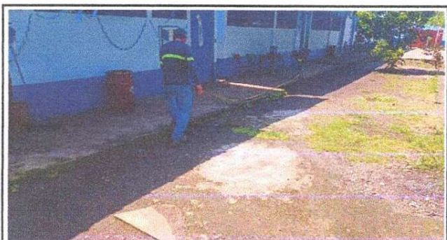
Foto 3: Sustrucción de losa de patio de concreto de 3" de espesor
