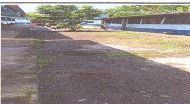
Foto 4: Sustrucción de losa de patio de concreto de 3" de espesor
