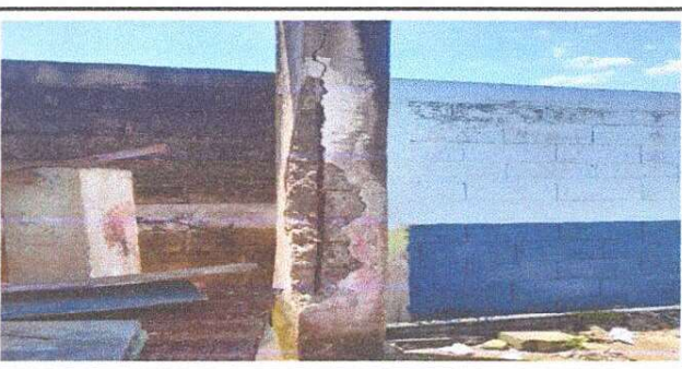
Foto 6: Sustrucción de torre de concreto en mal estado por Torre de Estructura Metálica de 3 metros de altura
