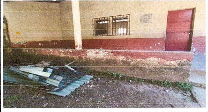
FOTO 2: Demolición de muro bajo
