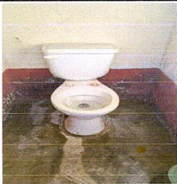
FOTO 3: Sustrucción de Inodoros + accesorios
