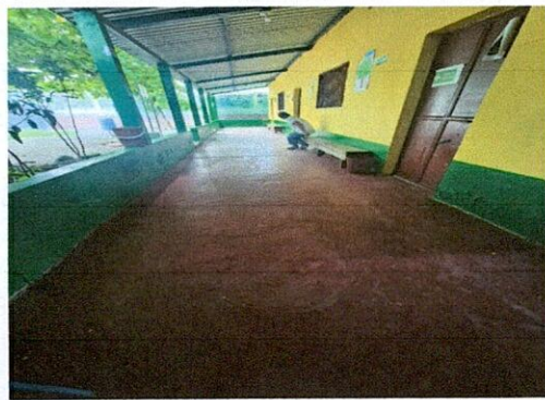
Foto 3: Sustitución de piso líquido por piso cerámico en módulo de aulas
