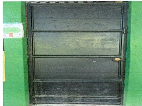
Foto 4: Sustitución de puerta de metal (1.96x0.87)
