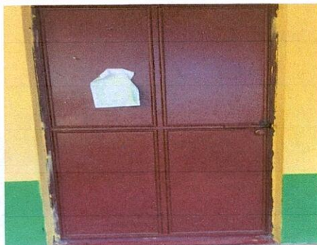
Foto 5: Mantenimiento a estructura de puertas (lijado, cepillado, sujeciones, aplicación de dos manos de pintura)
