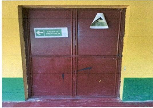
Foto 1: Mantenimiento a estructura de puertas (lijado, cepillado, sujeciones, aplicación de dos manos de pintura)
