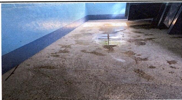
Foto 5: Sustitucion de piso granito
