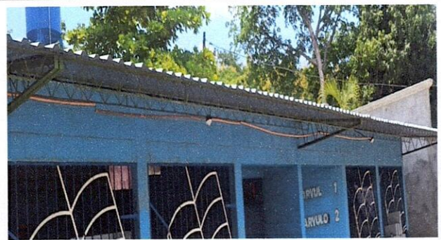
Foto 4: Suministro de cableado electrico y ventiladores dentro del aula
