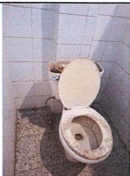
Foto 3: Sustitución de inodoro + accesorios
