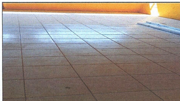
FOTO 4: SUSTITUCIÓN DE PISO DE CONCRETO POR PISO CERÁMICO EN 6 AULAS INCLUYE PSP+SIZADO
