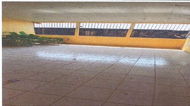
FOTO 1: SUSTITUCIÓN DE PISO DE CONCRETO POR PISO CERÁMICO EN 6 AULAS INCLUYE PSP+SIZADO
