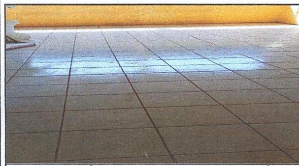
FOTO 5: SUSTITUCIÓN DE PISO DE CONCRETO POR PISO CERÁMICO EN 6 AULAS INCLUYE PSP+SIZADO
