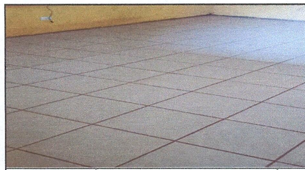
FOTO 6: SUSTITUCIÓN DE PISO DE CONCRETO POR PISO CERÁMICO EN 6 AULAS INCLUYE PSP+SIZADO
