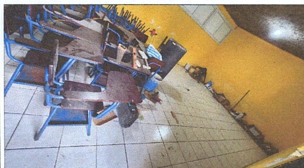
FOTO 3: SUSTITUCIÓN DE PISO DE CONCRETO POR PISO CERÁMICO EN 6 AULAS INCLUYE PSP+SIZADO
