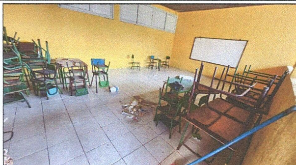
FOTO 2: SUSTITUCIÓN DE PISO DE CONCRETO POR PISO CERÁMICO EN 6 AULAS INCLUYE PSP+SIZADO
