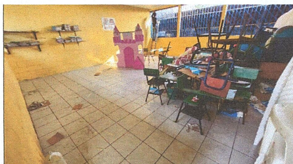
FOTO 4: SUSTITUCIÓN DE PISO DE CONCRETO POR PISO CERÁMICO EN 6 AULAS INCLUYE PSP+SIZADO
