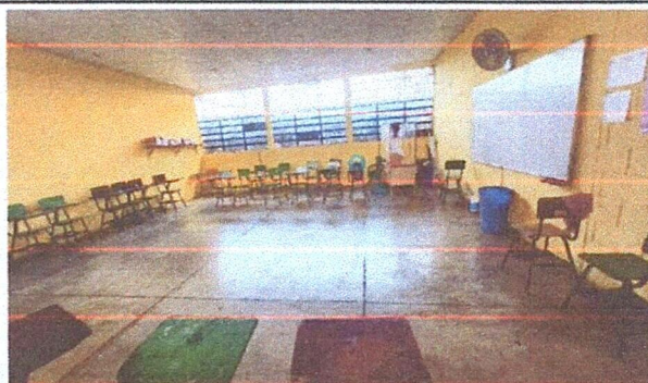
FOTO 4: SUSTITUCION DE PISO DE CONCRETO POR PISO CERAMICO EN 6 AULAS INCLUYE PSP + SIZADO
