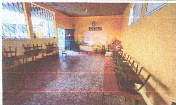
FOTO 1: SUSTITUCION DE PISO DE CONCRETO POR PISO CERAMICO EN 6 AULAS INCLUYE PSP + SIZADO
