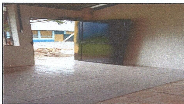
FOTO 4: SUSTITUCIÓN DE PUERTA DE METAL POR PUERTA DE METAL
