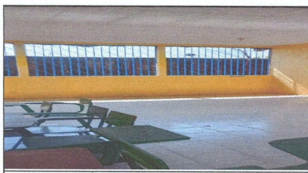
FOTO 6: SUSTITUCIÓN DE BALCONES
