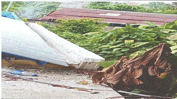
FOTO 1 : SUMINISTRO DE CANAL DE CONCRETO ARMADO
