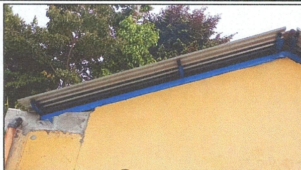
FOTO 2: SUSTITUCIÓN DE ESTRUCTURA DE SOPORTE DE TECHO
