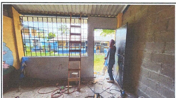
FOTO 4: SUSTITUCIÓN DE PUERTA DE METAL POR PUERTA DE METAL
