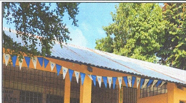
FOTO 2: SUSTITUCIÓN DE ESTRUCTURA DE SOPORTE DE TECHO
