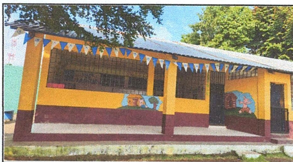
FOTO 5: SUSTITUCIÓN DE PISO Y NIVELACIÓN DE LOSA DE PATIO
