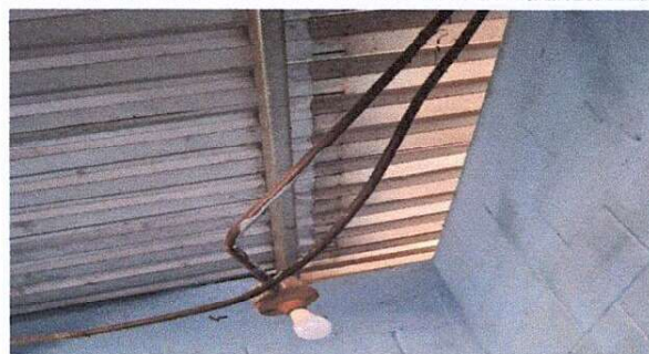
Sustitución de cableado de sistema eléctrico de iluminación
