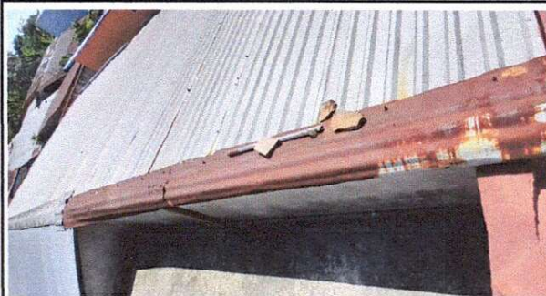
Sustitución de capote de metal
