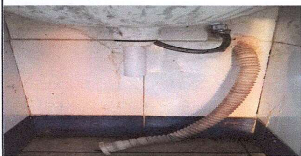
Mantenimiento de lavamanos (cambio de cifón y accesorios)
