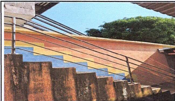
Aplicación de pintura en paredes exteriores e interiores + suministro de malla galvanizada + tubo galvanizado de 2"
