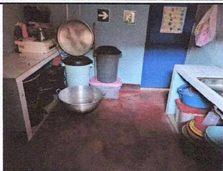
Sustitución de piso por piso cerámico
