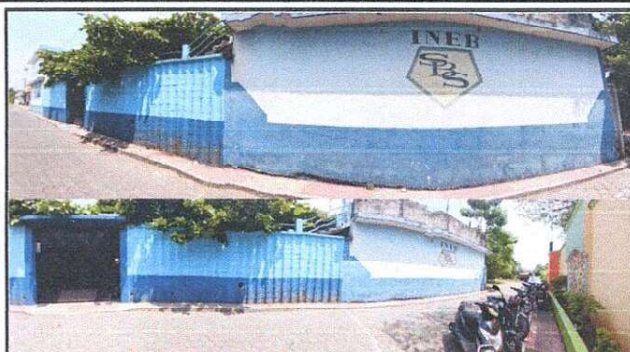
Foto 2: Aplicación de pintura en muros exteriores
