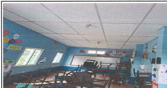
Colocación de cielo falso en 6 aulas.
