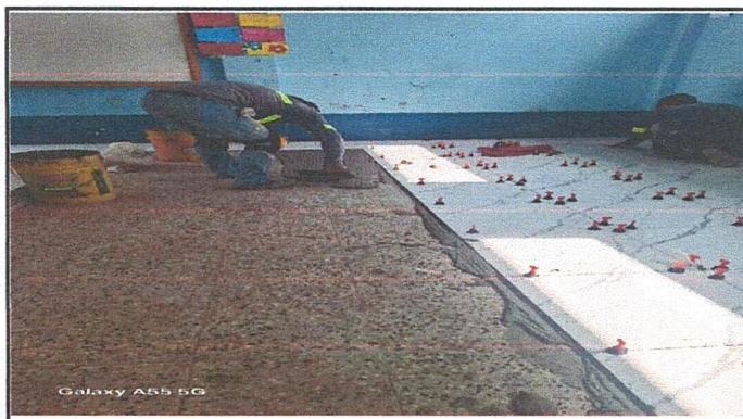
Sustitución de piso de granito por piso cerámico de porcelanato.
