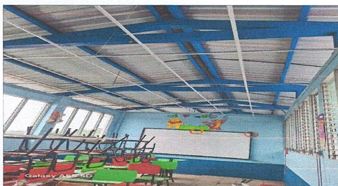
Colocación de cielo falso en 6 aulas.
