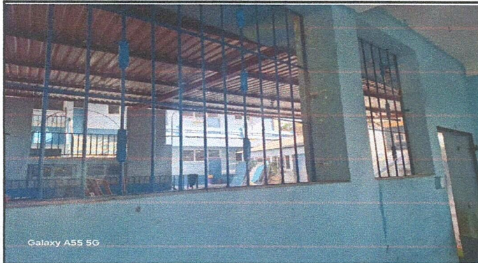
Sustitución de ventanas tipo balancin por ventanas PVC corredizas con sus respectivos balcones de hierro.
