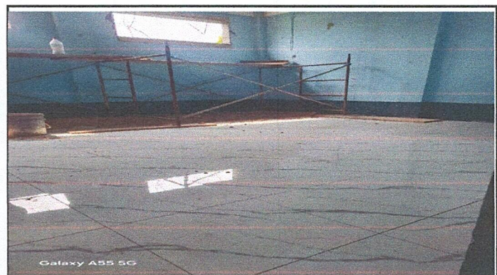
Colocación de piso cerámico de porcelanato, en anexo de cocina.
