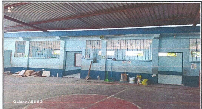
Sustitución de ventanas tipo balancin por ventanas PVC corredizas con su respectivo balcón de hierro.
