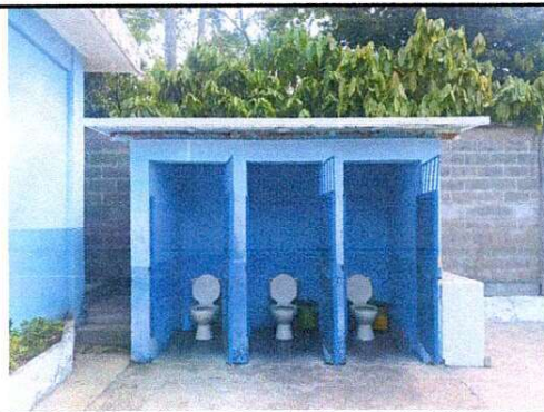
Foto 4: Sustitución de estructura + techo de lámina + sustitución de inodoros
