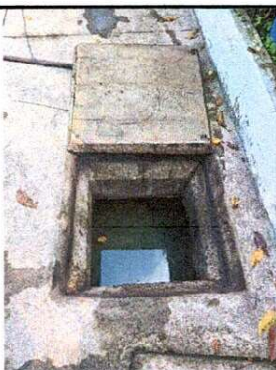
Foto 3: Mantenimiento de fosa séptica
