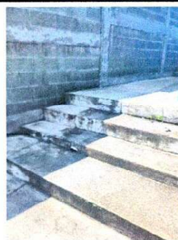
Foto 2: Suministr de rampa de acceso
