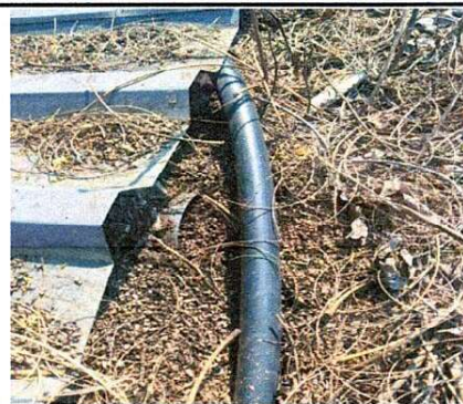
Foto 4: Sustitución de cableado eléctrico + ducto eléctrico + accesorios
