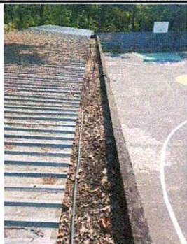
Foto1: Limpieza de canal de agua pluvial
