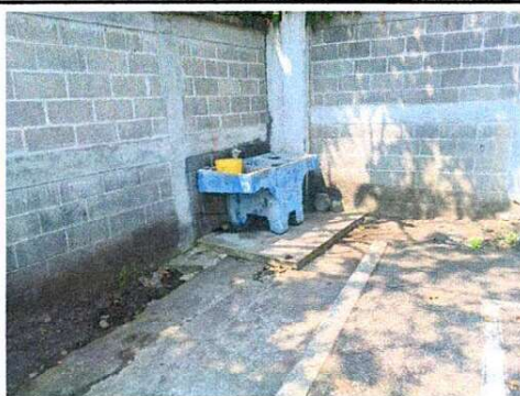
Foto 2: Sustitución de pila por pila de concreto
