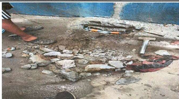
Foto 1: Reparación de red de drenajes
