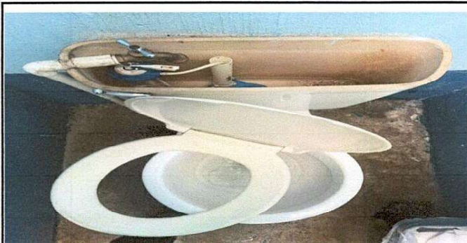
Foto 3: Sustitución de inodoros
