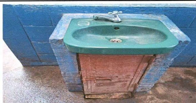
Foto 4: Sustitución de lavamanos de cerámica por lavamanos de concreto incluye 3 chorros
