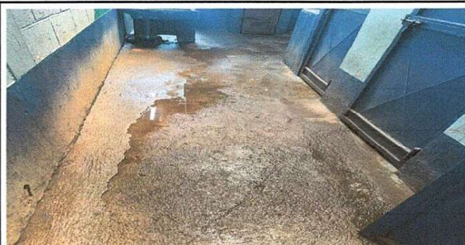
Foto 2: Sustitución de piso de torta de concreto por piso cerámico antideslizante + nivelación con mezclón
