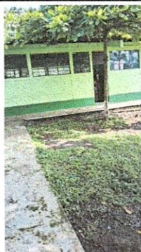
FOTO 5: Suministro de losa de patio t: 0.10
