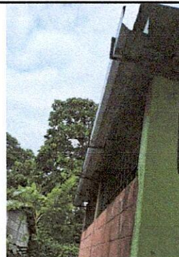
FOTO 2: Suministro de canal de metal + soporte pescante de metal + bajadas de agua pluvial 3"
