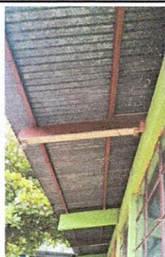
FOTO 3: Suministro de estructura portante de metal
