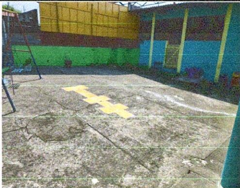
FOTO 3: Aplicación de pintura en muros interiores y exteriores
