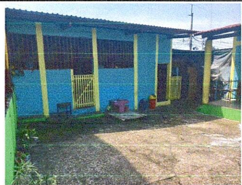
FOTO 4: Sustitución de lámina, por lámina troquelada aluzinc calibre 26, Sustitución de estructura de soporte de metal
