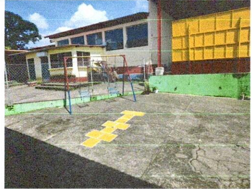
FOTO 2: Reparación de losa de patio de concreto t: 0.10
