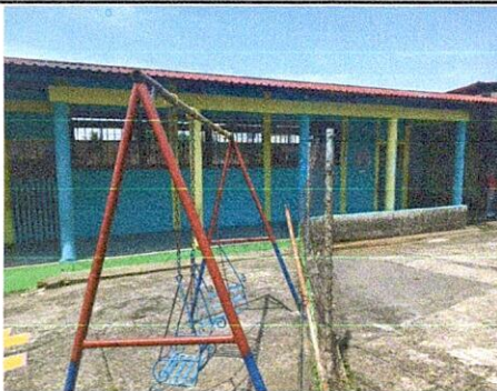
FOTO 5: Aplicación de pintura en muros interiores y exteriores
