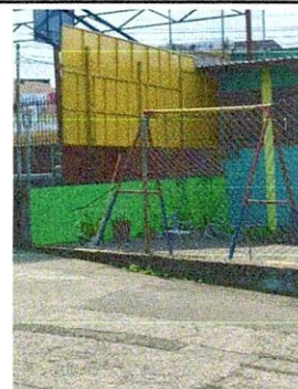
FOTO 6: Reparación de losa de patio de concreto t: 0.10
