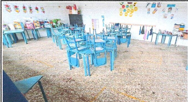
FOTO 4: Suministro de piso cerámico
