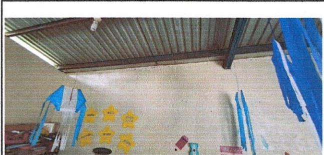
FOTO 2: Modificación de estructura portante de metal + mantenimiento (lijado, cepillado y aplicación de 2 manos de pintura R 15 anticorrosiva)
