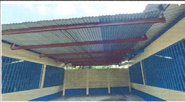
FOTO 1: Sustrucción de lámina troquelada aluzinc calibre 26
