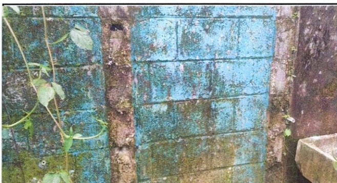
Foto 4: Reparación de muro de media altura + malla galvanizada de 1 1/2 plg
