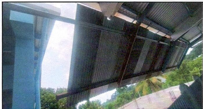
Foto 1: Reparación de estructura de techo en area de servicios multiple y pasillo de aulas
