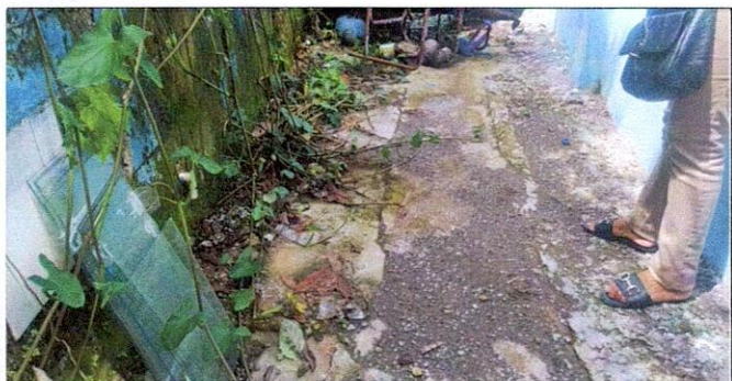
Foto 5: Reparación de losa de patio
