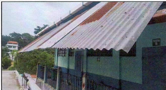
Foto 2: Suministro de canales y bajadas de agua pluvial
