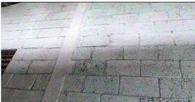
Foto 6: Aplicación de repello en paredes de muro de aulas interior y exterior
