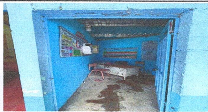
Foto 2: Sustitución de puerta de metal (incluye resanado y tallado de vano de puerta), sustitución de piso de concreto por cerámico
