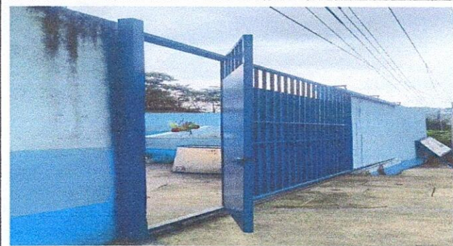
Foto 3: Suministro de estructura de soporte y cubierta de lámina para protección de portón de ingreso principal
