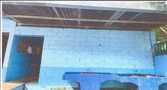
Foto 1: Sustitución de lámina, por lámina troquelada aluzinc calibre 26, mantenimiento de estructura
