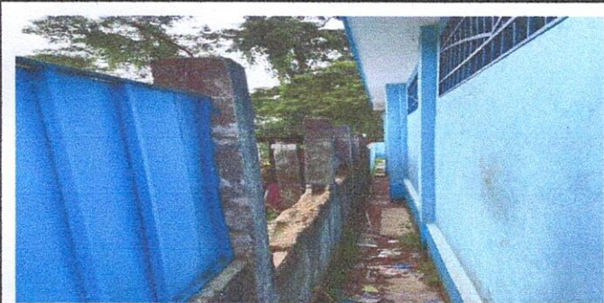
Foto 5: Suministro de balcón de metal para protección de muros perimetrales, incluye la fundición de soleras de concreto talladas
