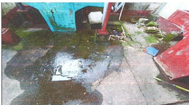
Foto 4: Reparación de planca de concreto de patio
