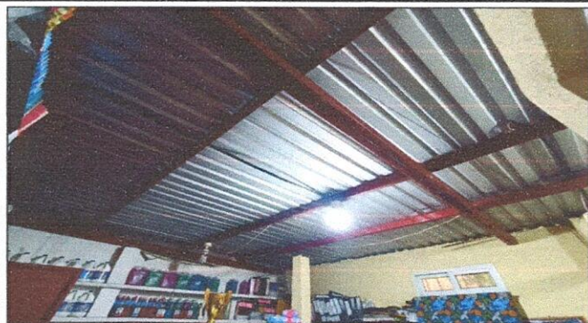
Foto1: Sustitución de estructura de metal y colocación de cielo falso de duropord
