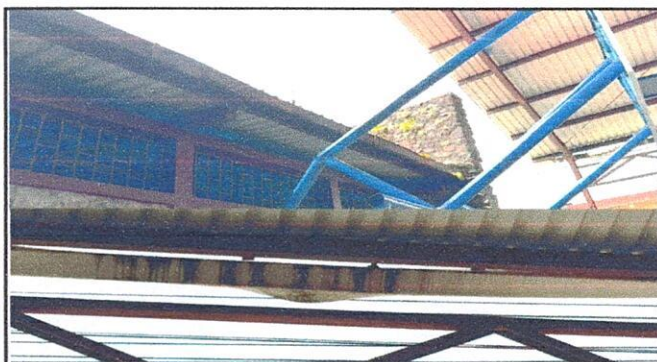
Foto 3: Sustitución de canal de metal por pvc
