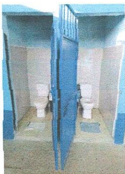
FOTO 3: Mantenimiento de puertas de metal de 1.00 x 2.20 + sustitución de chapas de metal
