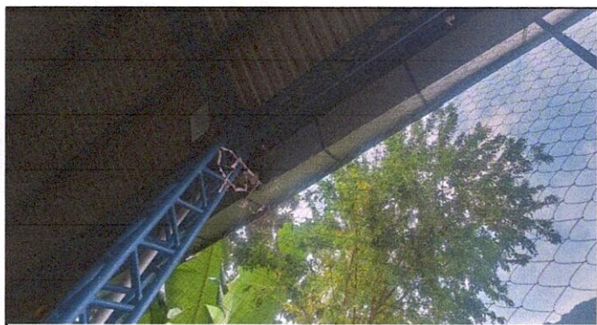
Foto 3: Sustitución de canal de metal existente por canal de metal fabricado con lámina lisa (con planchas de 4 pie por 8 pie calibre 18 + la sustitución de bajadas de ducto de 6" y 8" pulgadas
