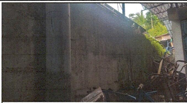
Foto 2: Aplicación de repello en pared de muro perimetral y muro de cocina
