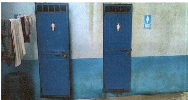
Foto 6: Reparación y mantenimiento a puertas de servicios sanitarios de 1.86X0.76 mt (Incluye lijado y cepillado + aplicación de pintura y cambio de chapa)
