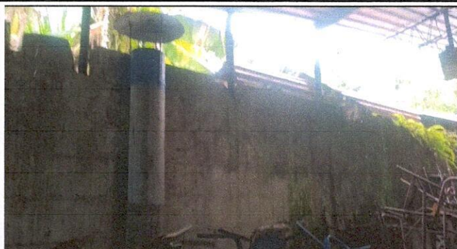
Foto 1:Mejoramiento de altura de muro de block en area de cocina + Refuerzo de seis columnas de 15*20 cm
