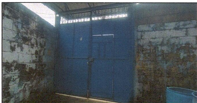
Foto 5: Reparación y mantenimiento a porton principal de 3.15x3.10 mts (incluye lijado cepillado + aplicación de pintura)
