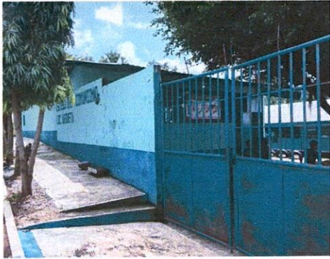
FOTO 1: Aplicación de pintura en muros interiores y exteriores
