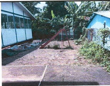
FOTO 5: Suministro de losa de patio t: 0.10
