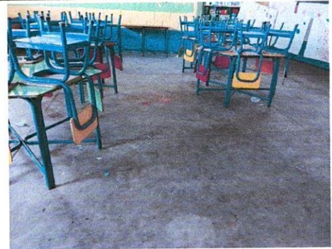
FOTO 6: Sustitución de piso cerámico
