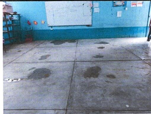
FOTO 2: Sustitución de piso cerámico
