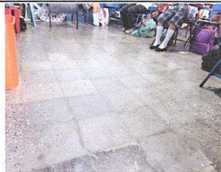
FOTO 6: Sustitución de piso de granito por piso cerámico
