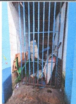
FOTO 1: Cerramiento de muro para bodega (incluye aplicación de repello y cernido + pintura)
