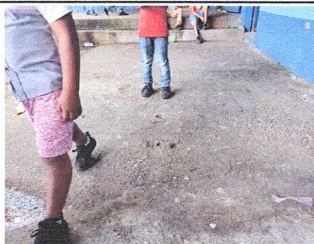
FOTO 2: Reparación de planchas de concreto de patio t:0.10
