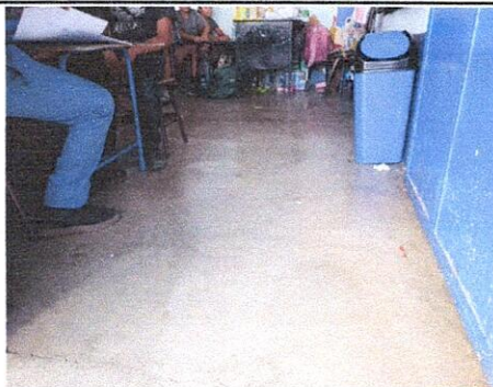
FOTO 4: Sustitución de piso de granito por piso cerámico
