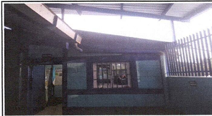
Foto 4: Sustitución de estructura de soporte de metal galvanizada 4x2 ch.16 espesor 1.52 (Incluye pintura y soldadura)
