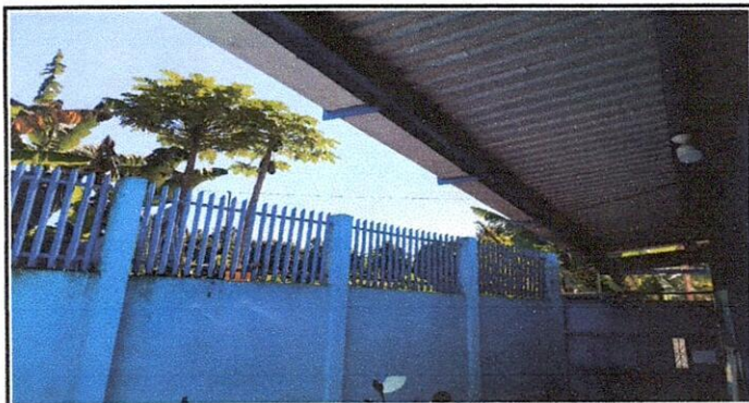
Foto 3: Sustitución de estructura de soporte de metal galvanizada 4x2 ch.16 espesor 1.52 (Incluye pintura y soldadura)
