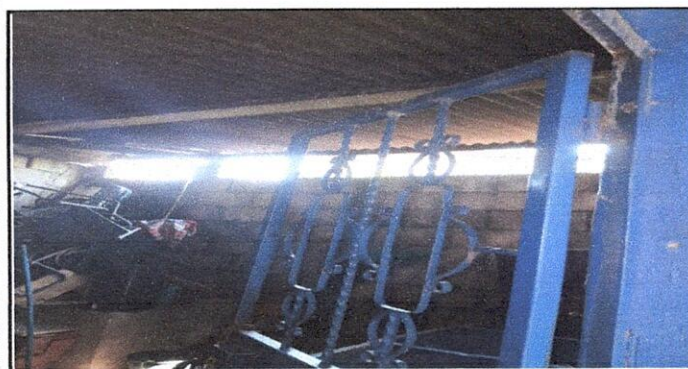
Foto 5: Mejoramiento de altura de muro de block sizado en aulas para cambio de pendiente de techo
